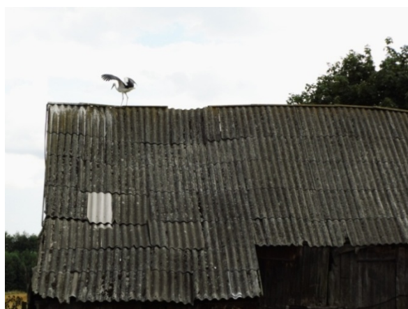
Rys. 1. Wyroby azbestowo – cementowe: po lewej płyty faliste, po prawej płyty płaskie, typ „Karo”. (źródło: materiały własne)
