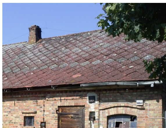
Rys. 1. Wyroby azbestowo – cementowe: po lewej płyty faliste, po prawej płyty płaskie, typ „Karo”. (źródło: materiały własne)
